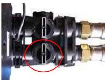
Bypass in bedrijf (Gesloten)
